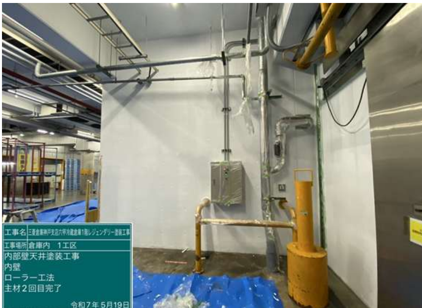
工事名 三菱倉庫神戸支店六甲冷蔵倉庫1期レジデンスリ-塗装工事 工事場所 倉庫内 1工区 内部壁天井塗装工事 内壁 ロール-工法 主材2回目作業中 令和7年5月19日
