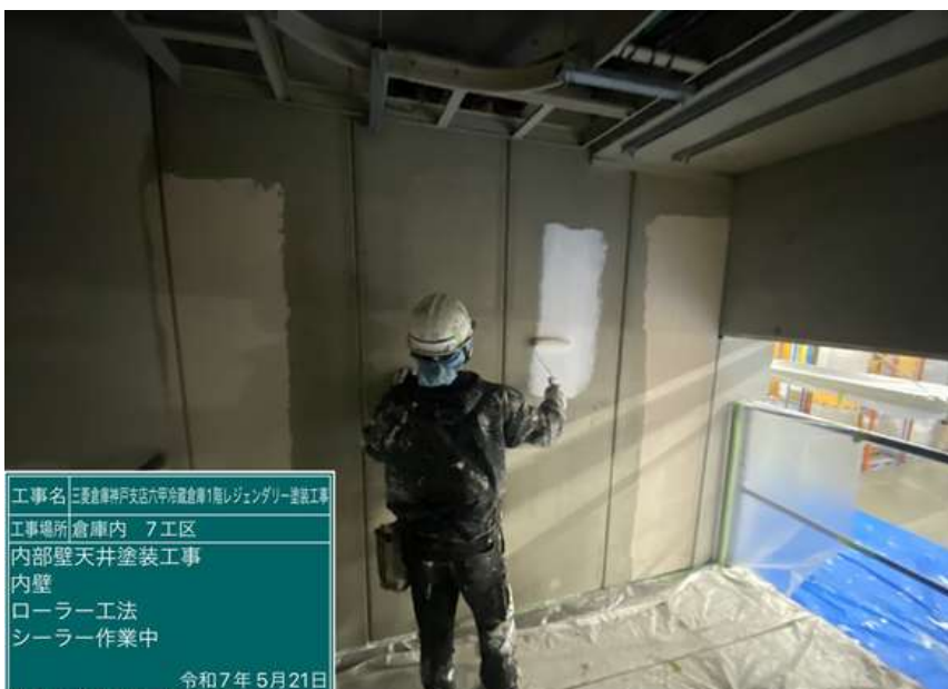
工事名 三菱倉庫神戸支店六甲冷蔵倉庫1階レジングレリー塗装工事 工事場所 倉庫内 7工区 内部壁天井塗装工事 内壁 ローラー工法 ケレン 令和7年5月21日
