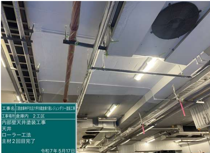
工事名 三菱倉庫神戸支店六甲冷蔵倉庫1階レジェンダリー塗装工事 工事場所 倉庫内 2工区 内部壁天井塗装工事 天井 ローラー工法 主材2回目作業中 令和7年5月17日
