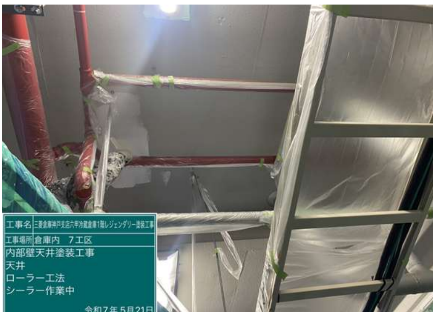
工事名 三菱倉庫神戸支店六甲冷蔵倉庫1階レジングレリー塗装工事 工事場所 倉庫内 7工区 内部壁天井塗装工事 天井 ローラー工法 ケレン 令和7年 5月21日
