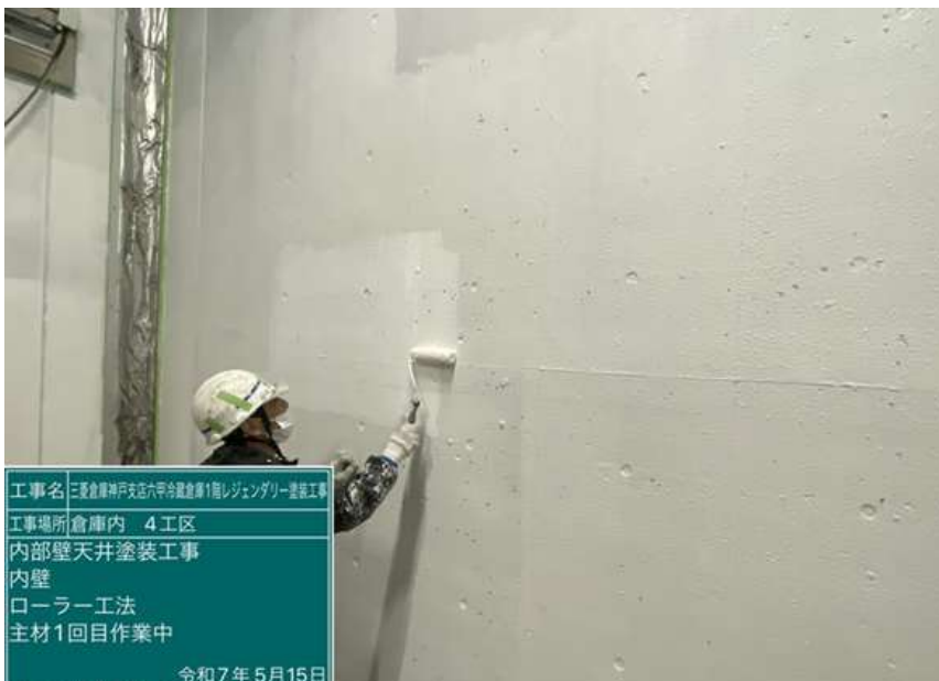
工事名 三菱倉庫神戸支店六甲冷蔵倉庫1階レジェンダリー塗装工事 工事場所 倉庫内 4工区 内部壁天井塗装工事 内壁 ローラー工法 シーラー完了 令和7年5月14日
