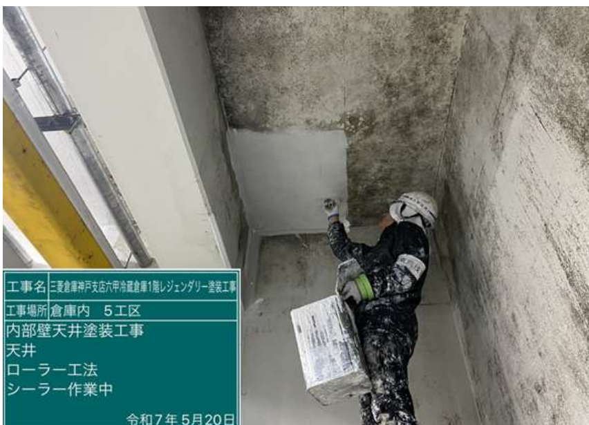
工事名 三菱倉庫神戸支店六甲冷蔵倉庫1階レジングレリー塗装工事 工事場所 倉庫内 5工区 内部壁天井塗装工事 天井 ローラー工法 ケレン 令和7年5月20日
