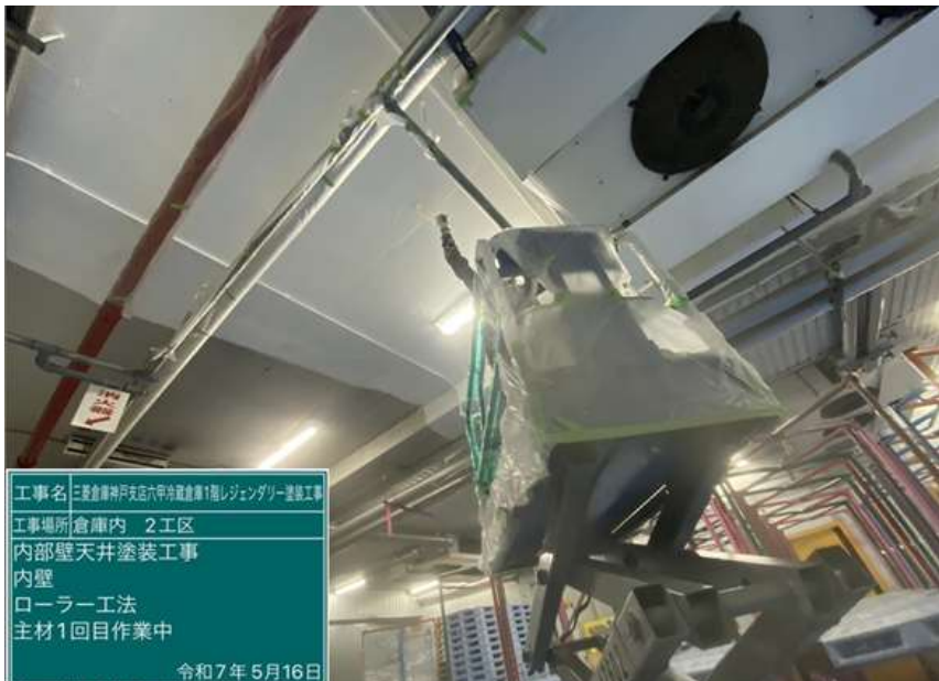
工事名 三菱倉庫神戸支店六甲冷蔵倉庫1階レジェンダリー塗装工事 工事場所 倉庫内 2工区 内部壁天井塗装工事 天井 ローラー工法 シーラー完了 令和7年5月13日
