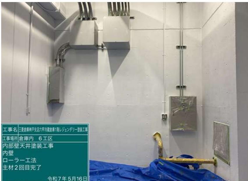
工事名 三菱倉庫神戸支店六甲冷蔵倉庫1階レンダリー塗装工事 工事場所 倉庫内 6工区 内部壁天井塗装工事 内壁 ローラー工法 主材2回目作業中 令和7年5月16日
