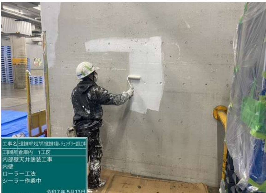
工事名 三菱倉庫神戸支店六甲冷蔵倉庫1階レジェンダリー塗装工事 工事場所 倉庫内 1工区 内部壁天井塗装工事 内壁 ロールー工法 ケレン 令和7年5月13日
